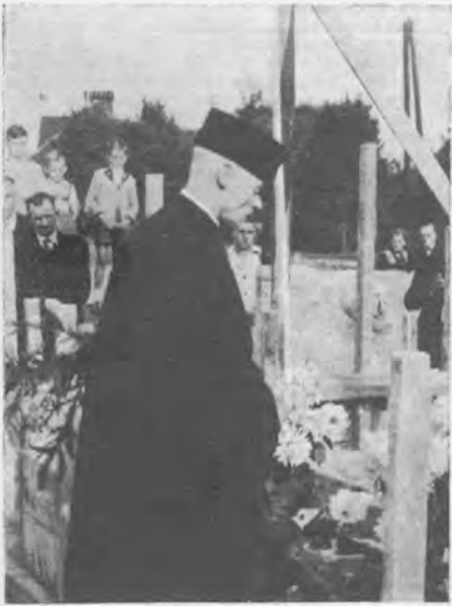
Pfarrer Schreiber bei der Grundsteinlegung des ev. Gemeindehauses in Angermund
