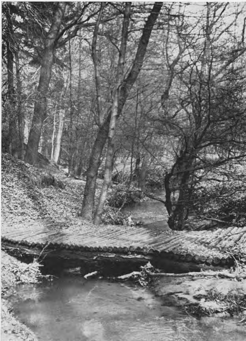
Holzbrücke über dem Dickelsbach im Lintorfer Wald 1969
