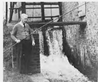
Am Schütt der Helfensteinmühle 19
