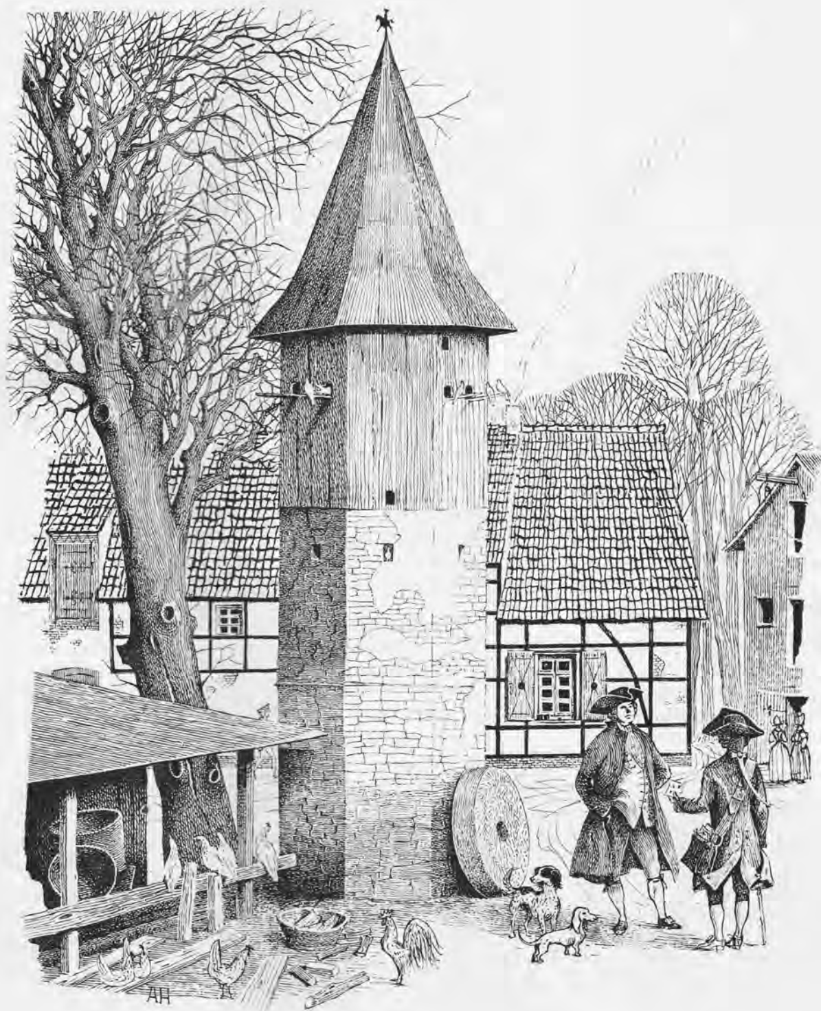
Die Helfensteinmühle zur Zeit der Herren von Pempelfort im 18. Jahrhundert Zeichnung von A. Heinen
