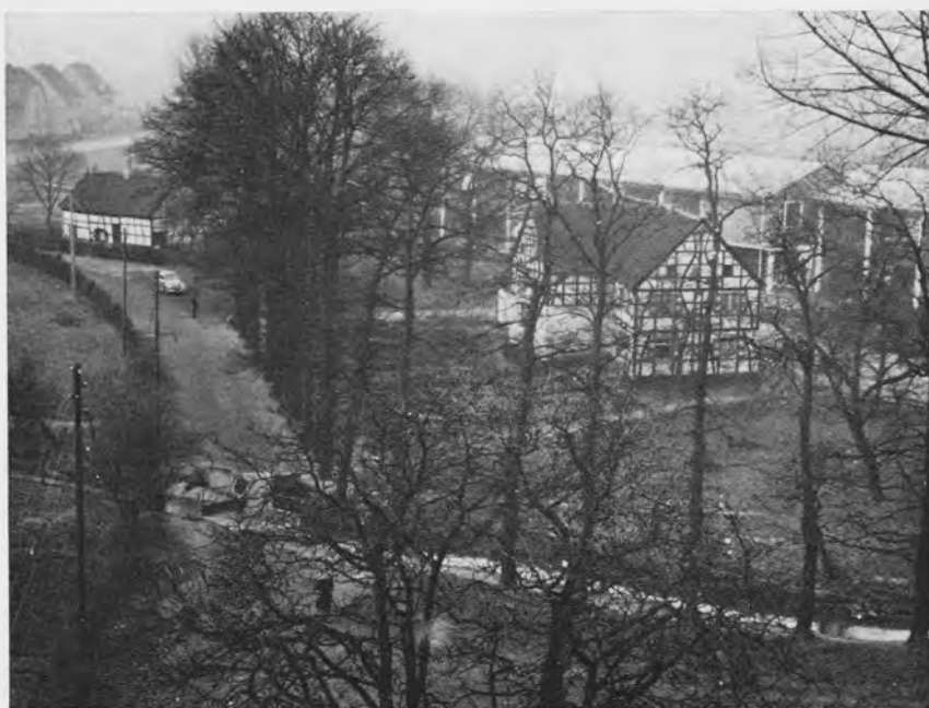
Die alte Hinüberstraße führte vom Dickelsbach zur Marzellistraße (Tiefenbroicher Straße). Gegenüber dem 1957 abgerissenen Gut Am Stein (Brückersgut) lag neben dem kurmedigen Marzelligut der Alte Wedenhof.
