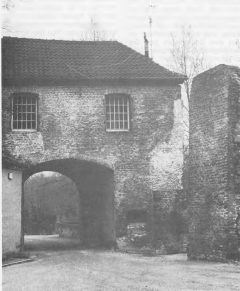
Eingang zur Kellnerei
