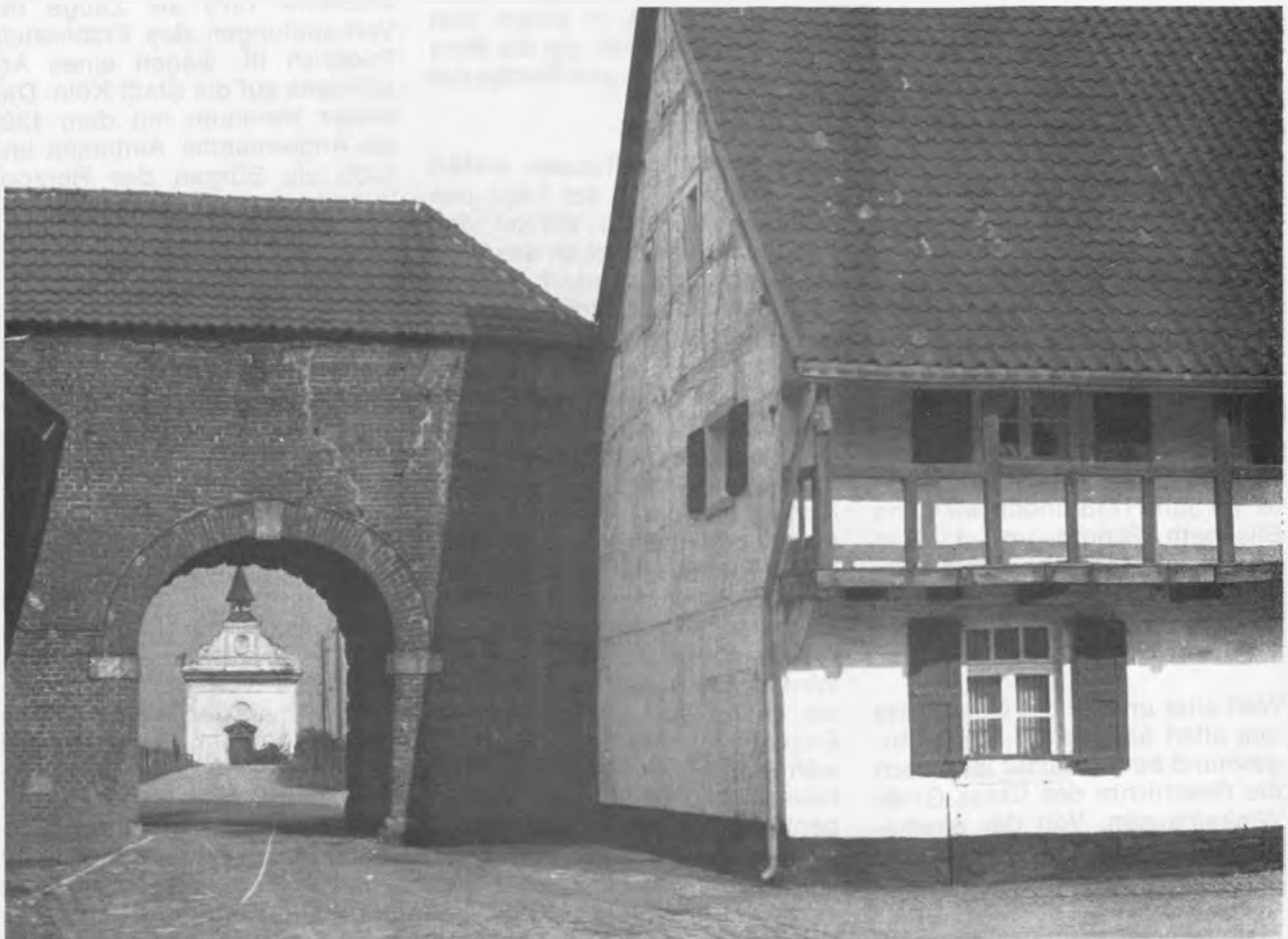
Groß-Winkelhausen: Blick durch die Toreinfahrt auf die Kapelle
