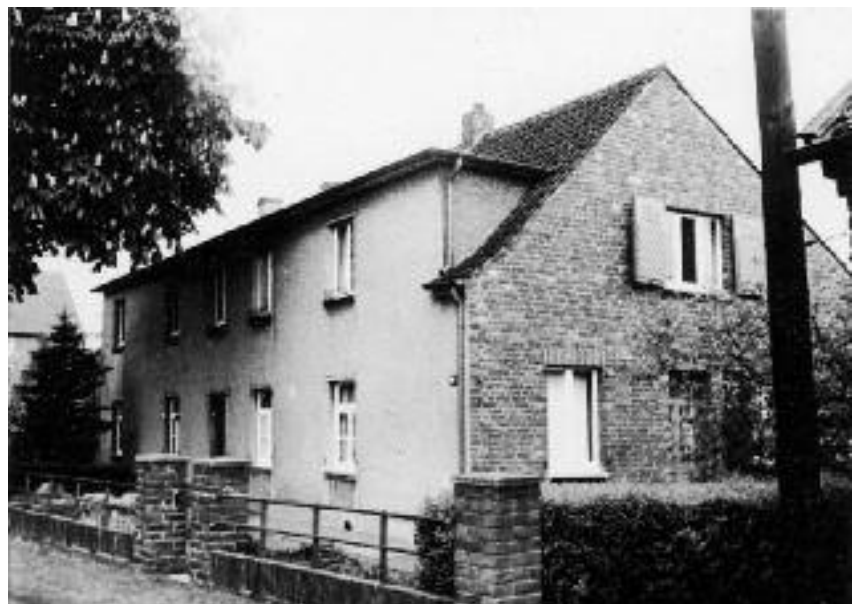
Das Haus der Speckamps trägt heute die Hausnummer Wedenhof 12. In den 1930er-Jahren wurde das Dachgeschoss ausgebaut
