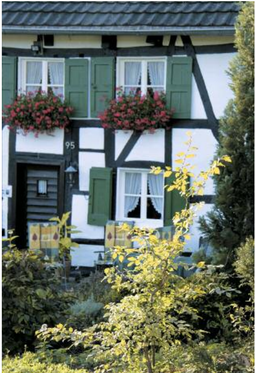
Das Fachwerkhaus in Hösel
