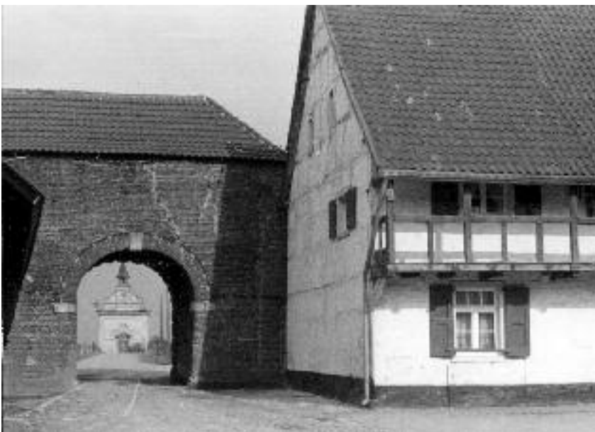
Blick vom Innenhof des Rittergutes durch das Torhaus auf die St.-Hubertus-Kapelle. Das Fachwerkwohnhaus verfügt noch über eine Holzgalerie in der ersten Etage. Das Foto entstand im Sommer 1974
