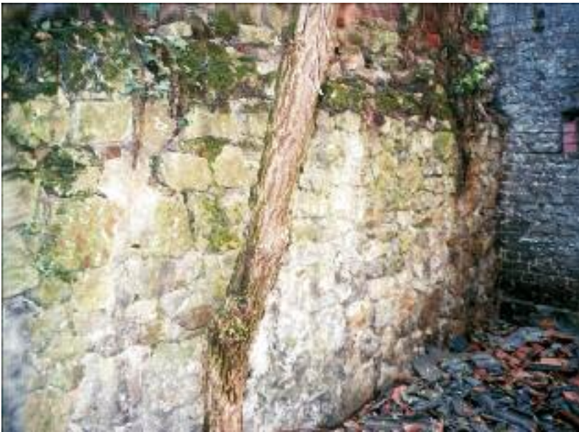
Rest der Oberdorfmauer im Hof des Abrisshauses Mülheimer Straße 10 (Aufnahme vom 28. 8. 2014)
