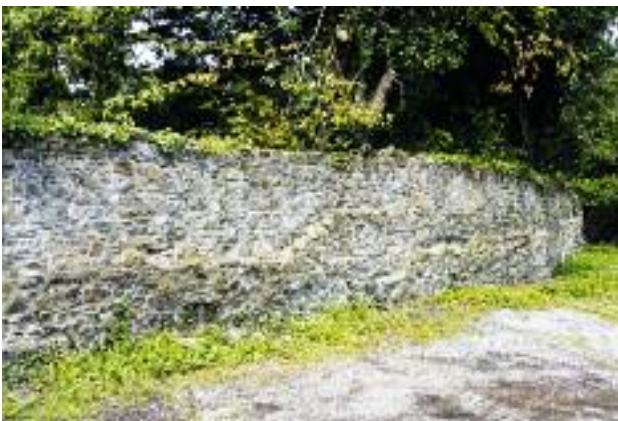
Die südliche Mauer des Oberdorfes hinter dem Restaurant „La Taverna“
