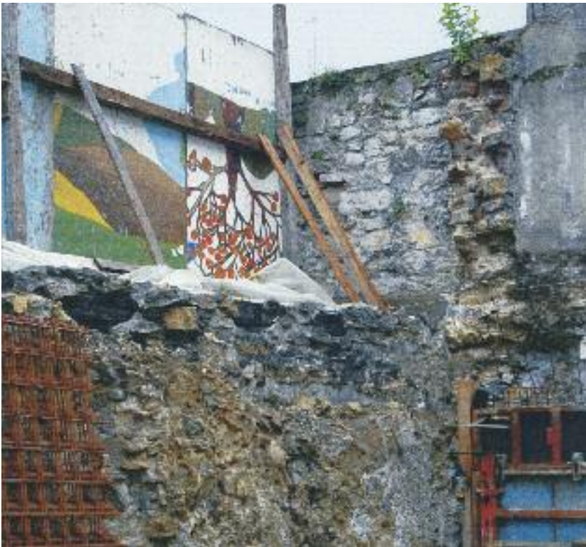
Baugrube Mülheimer Straße 6. In der Grube sind starke Fundamentmauern zu erkennen. Im Hintergrund sieht man an der Rückseite des Grundstücks ein angeschnittenes Stück der alten Oberdorfmauer
