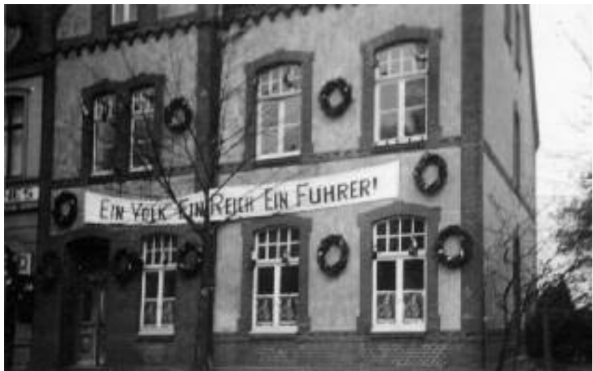
Die Geschäftsstelle der NSDAP, Ortsgruppe Lintorf, an der früheren Angermunder Straße Nr. 28 (Ehemaliges Kaiserliches Postamt) am 18. März 1938, dem „Tag des Anschlusses“ Österreichs an das Deutsche Reich
