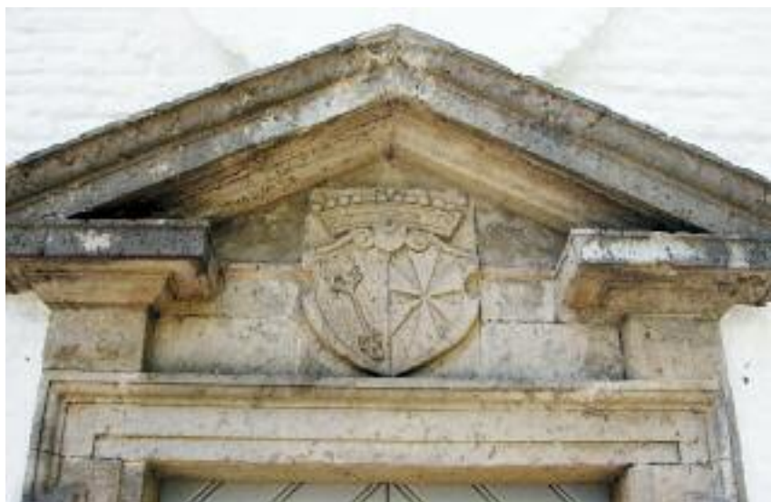
Über dem Giebelportal der Kapelle findet sich unter einem Rundbogen mit Kreuz das zusammengeführte Wappen der Herren von Winkelhausen mit dem Teerfackeleisen und der Freiherren von Wachtendonk mit dem Stern
