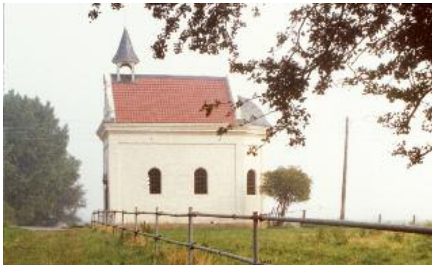
Bei der Hubertuskapelle handelt es sich um einen schlichten rechteckigen Backsteinbau mit einem wohlproportionierten Barockgiebel und Voluten, einer Chorapsis und einem einfachen Dachreiter auf dem Dach
